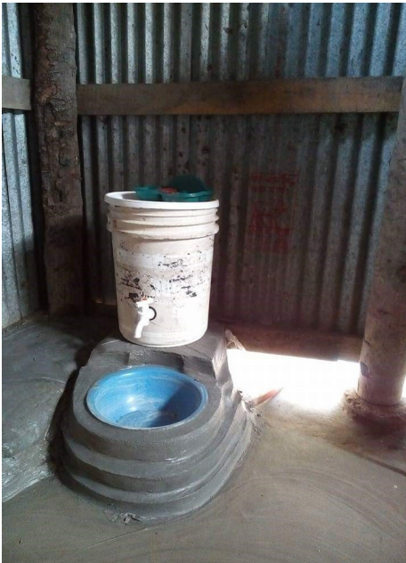
استخدام حاويات الدهان مع حنفية، يتم تركيبها داخل المطبخ إلى جانب وعاء بلاستيكي كحوض
