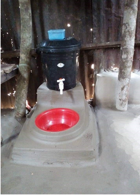
لو مع حنفية، يتم تركيبه داخل المطبخ إلى جانب وعاء بلاستيكي كحوض
