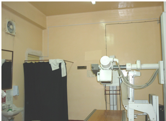
Los servicios de Rx deben contar con ventilación adecuada
