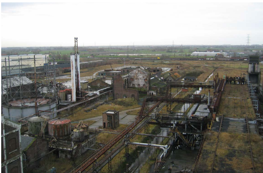
Cokerie abandonnée à Zeebrugge (Belgique) ©Société publique des déchets de la Région flamande
