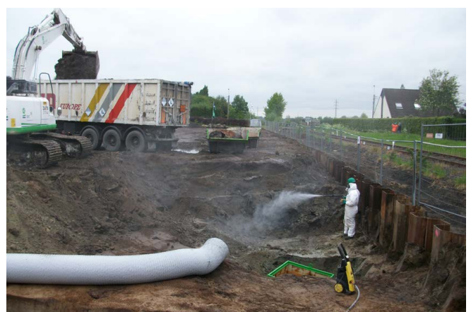
Erdarbeiten auf einer ehemaligen Deponie, Buggenhout (Belgien) © Öffentliche Abfallagentur von Flandern
