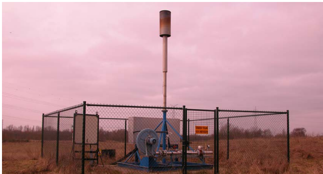
Entgasung eines ehemaligen Deponiebereichs, Schelle (Belgien) © Öffentliche Abfallagentur von Flandern
