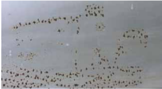
El cloro corroe el acero inoxidable
