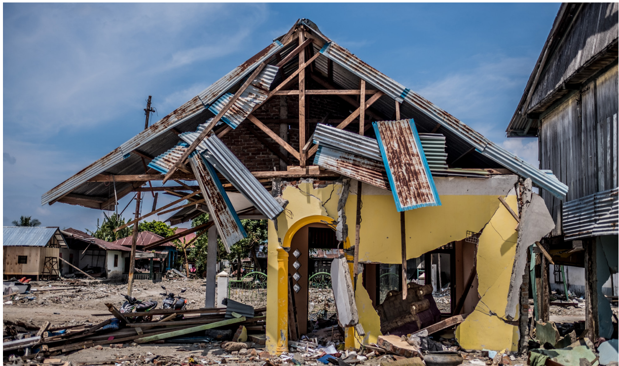
Destruction des infrastructures suite au tremblement de terre et au tsunami de septembre 2018 qui ont frappé Palu, en Indonésie. Crédit image : IPPF/Kathleen Prior/Indonésie
