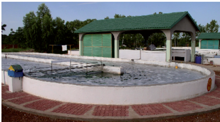
Bassin de l'unité industrielle de production de spiruline à Koudougou (100 km à l'Ouest de Ouagadougou, Burkina Faso)
