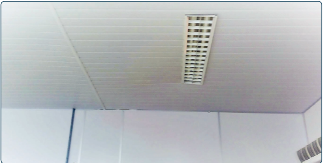
Figura 1. Ejemplo de rebajamiento de techo
