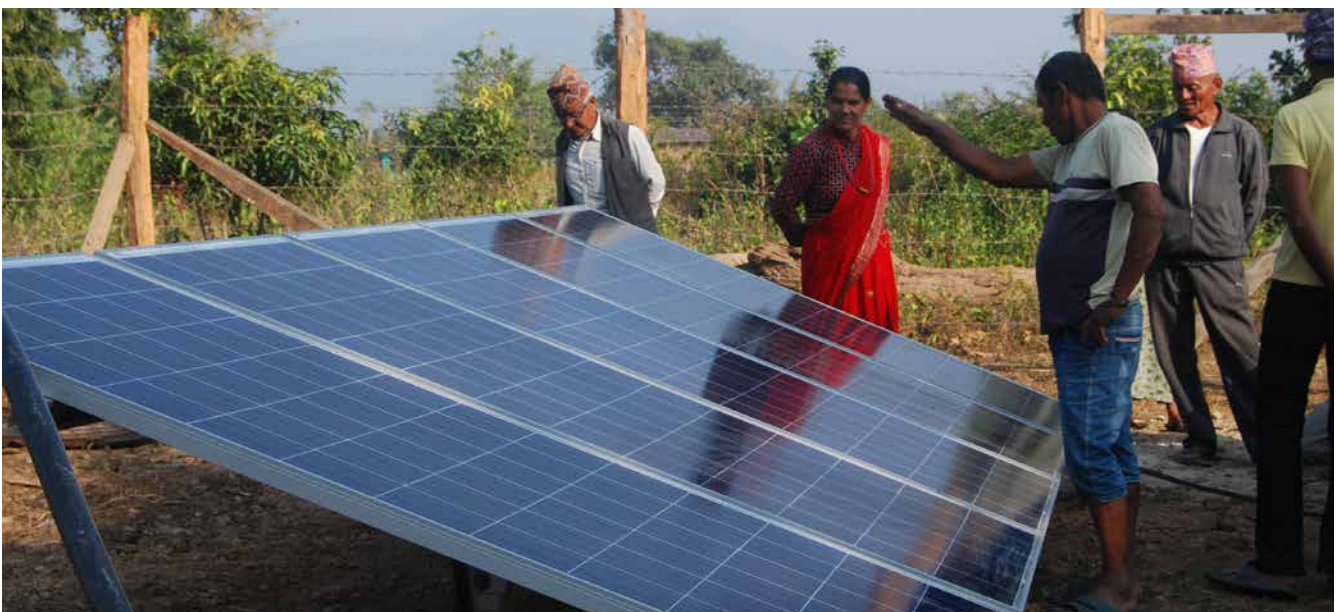
ภาพที่ 15: การติดตั้งระบบชลประทานพลังงานแสงอาทิตย์ในประเทศเนปาลเพื่อรวบรวมน้ำจากแม่น้ำไปยังท่อซึ่งจะใช้สำหรับการชลประทานในช่วงฤดูแล้ง
