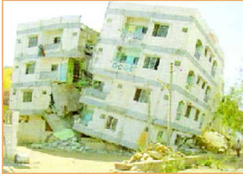
၂၀၀၁ခုနှစ်အိန္ဒိယနိုင်ငံ၊ဂျာဂရတ်ငလျင်ဖြစ်ပေါ်စဉ်က တိမ်းစောင်းသွားသောအဆောက်အအုံ
