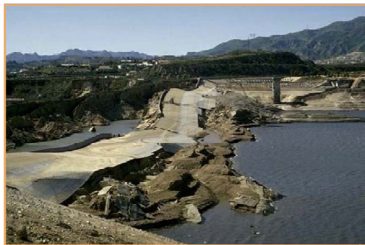
၁၉၇၁ခုနှစ်ဆန်ဖာနန်ဒိုငလျင်တွင်ပျက်ဆီးခဲ့သော ဗင်နီမန်ဆည်(အောက်ဖက်)
