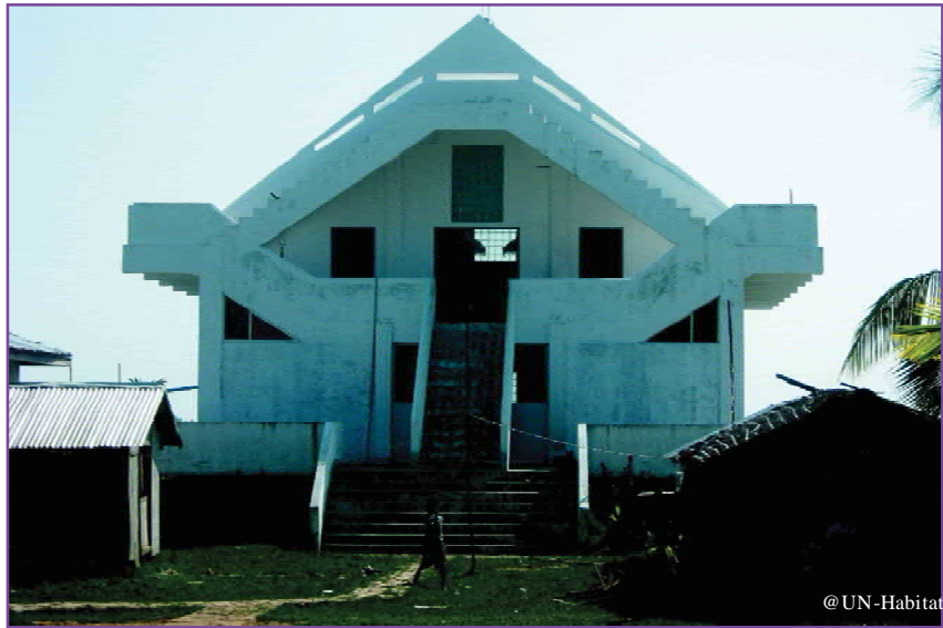
ဒေးဒရဲမြို့နယ်၊ ကန်ဆိပ်ကျေးရွာအုပ်စု၊ သကြားဟင်းအိုးကျေးရွာတွင် ရပ်ရွာလူထုအတွက်ဆောက်လုပ်ထားသောဆိုင်ကလုန်း ခိုလှုံရာအဆောက်အအုံ
