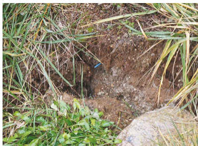
Figure 18. Traces de frottement laissées par des rats (© Bureau d'inspection à l'entrée et à la sortie et de quarantaine de Shanghai, Chine)
