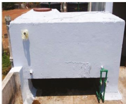
Figure 43. Tubulure d'évacuation des gaz d'une installation septique hors sol recouverte d'une gaze de nylon © Ashwani Kumar
