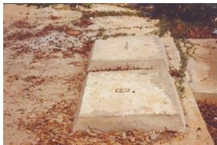
Figure 41. Des fosses septiques hermétiquement fermées empêchent la prolifération des culicidés, notamment de Culex quinquefasciatus © Ashwani Kumar
