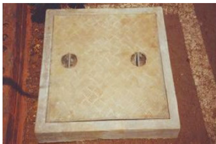
Figure 40. Une fois mis en place, ce couvercle à l'épreuve des moustiques est bien ajusté à la bordure du regard de la chambre de distribution © Ashwani Kumar
