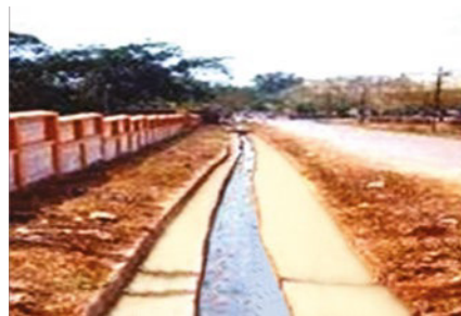
Figure 39. Les berges rectilignes de cette tranchée de drainage permettent un bon écoulement de l'eau © Ashwani Kumar
