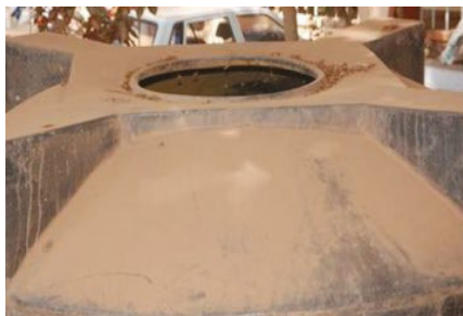
Figure 36. Citerne ouverte posée en surface à proximité d'un chantier de construction © Ashwani Kumar
