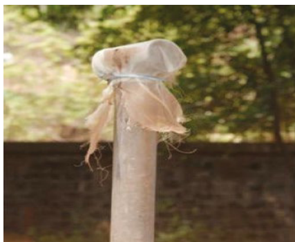
Figure 42. L'extrémité à l'air libre de la tubulure d'évacuation des gaz doit être recouverte d'une gaze de nylon © Ashwani Kumar
