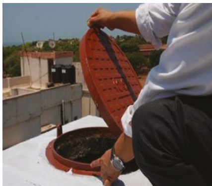
Figure 44. Couvercle d'un réservoir hors sol à l'épreuve des moustiques © Ashwani Kumar
