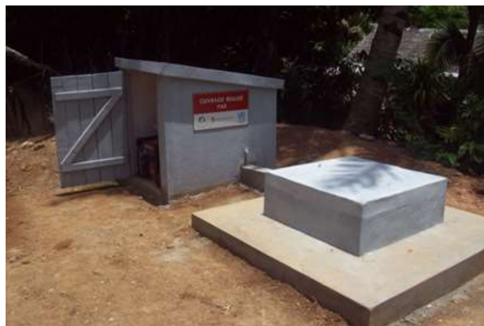
Un Puits construit dans le cadre du projet Monaco/OMS/MSANP avec abri de la motopompe
