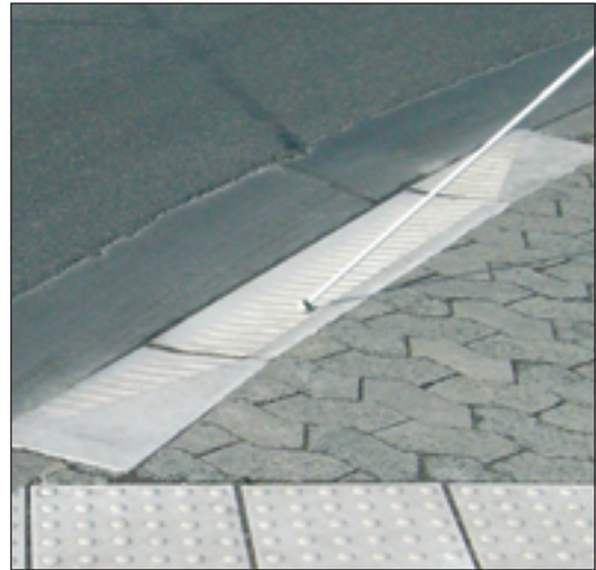
Fig. 39 : Applications hautement contrastantes, tactiles et biseautées sur les passages piétons
