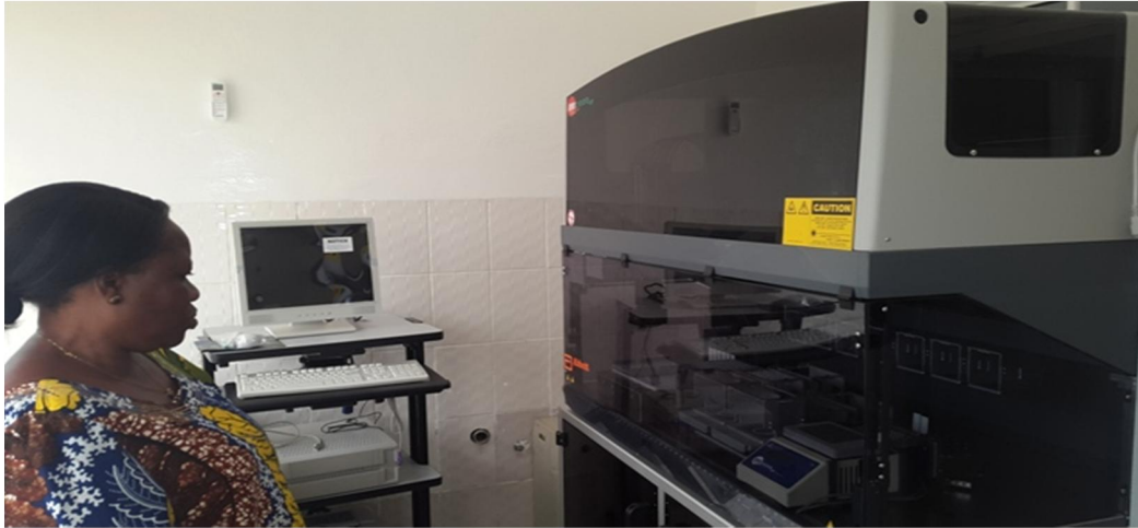
Vue de la responsable de laboratoire PNLS Lubumbashi qui visite les équipements installés dans le laboratoire réhabilité.
