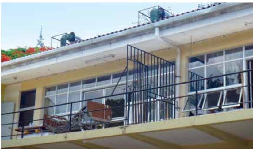
Foto 15: Visualización externa del cuarto de aislamiento respiratorio del Servicio de Neumología. Se observan los inyectores de aire en el techo de dichos cuartos.
