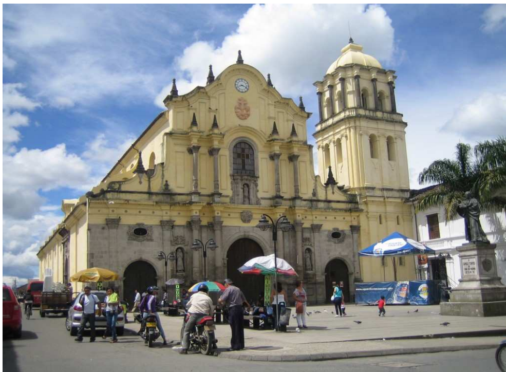
Popayán. Iglesia de San Francisco, reconstruida por la Cooperación internacional española. Fuente: Javier Segura, noviembre 2011
