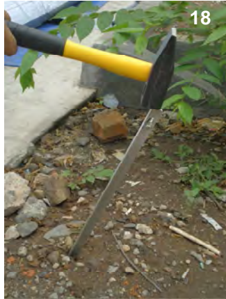
17. dan 18. Tanam pasak di tanah padat/keras dengan posisi menyamping.
