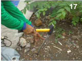
17. dan 18. Tanam pasak di tanah padat/keras dengan posisi menyamping.
