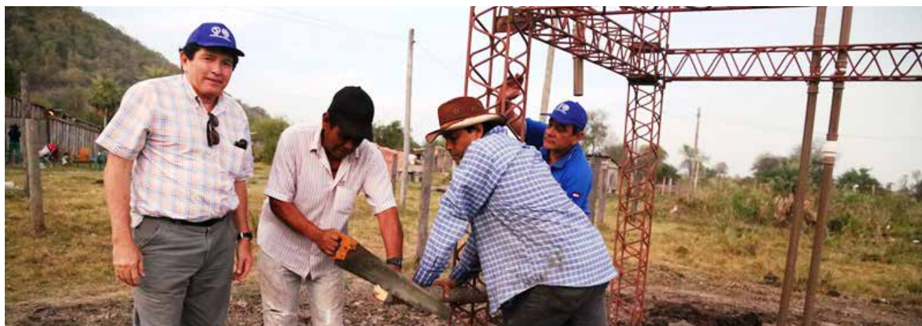
Mejoramiento del sistema de agua
