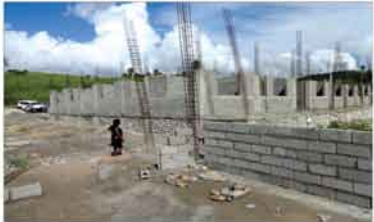
Centre de Santé de Roche à Bateau (Commune Roche à Bateau) Financement – Trésor Public-Investissement
