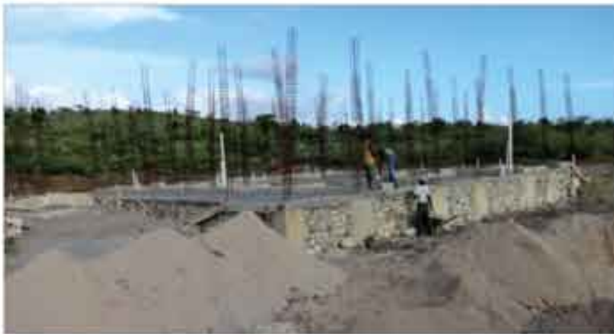
Construction du Centre de Santé de Tiburon Financement – Trésor Public-Investissement
