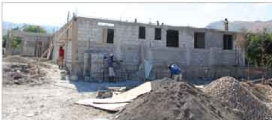
Construction du Centre de Santé de Petite Rivière Bayonnais – Financement Trésor Public (Investissement)
