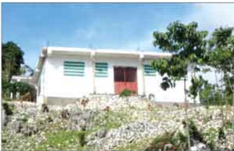
Construction du Centre de santé de Golbothine (Roseaux) - Financement Trésor Public (Fonds Communaux)
