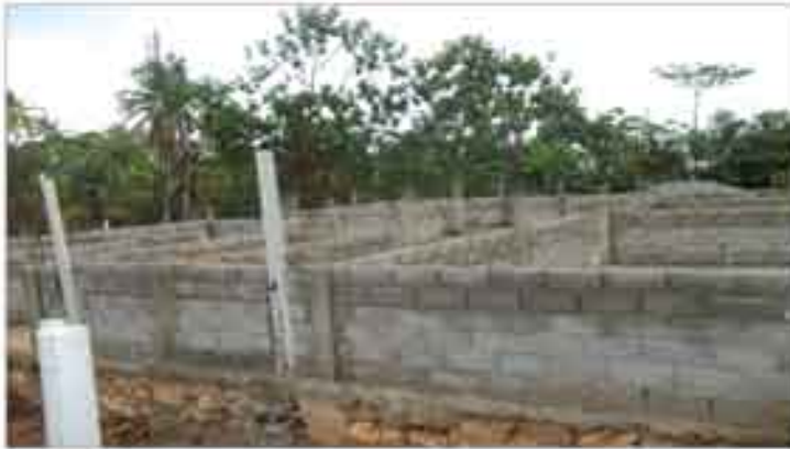
Construction du Centre de santé de St Victor (Abricots) Financement- Trésor Public (Investissement)
