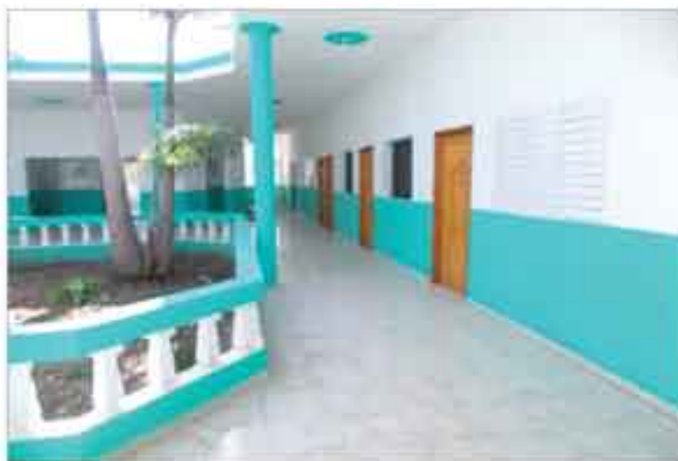
Réhabilitation du Centre de Boc Banik (Thomassique) Financement Trésor Public (Investissement)
