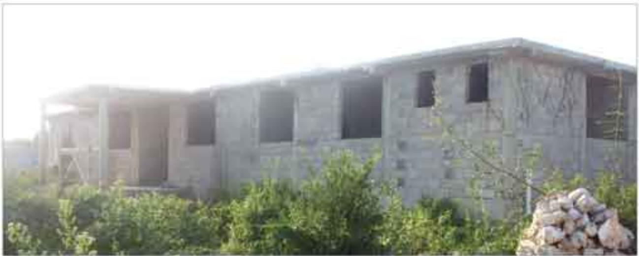
Construction du Centre de santé d' Anse à Masson (Cayemittes) Financement: Trésor Public (Investissement)
