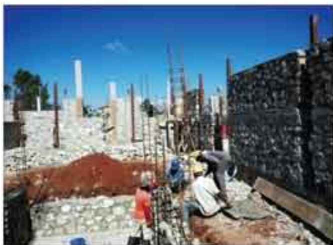
Construction du Centre de Santé de Montagne Terrible (Saut d'eau) - Financement Trésor Public (Investissement)
