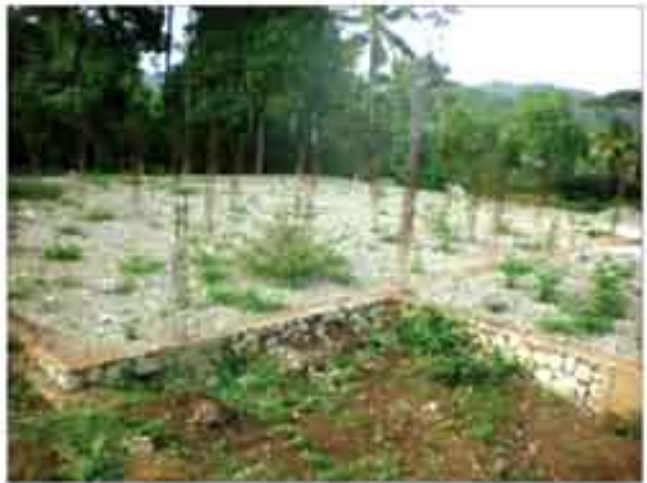
Construction du Centre de santé de Tozia (Pestel) Financement- Trésor Public (Investissement)
