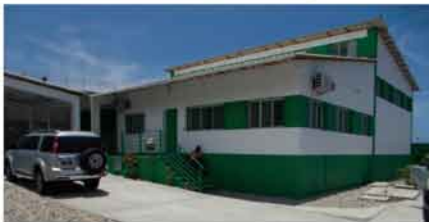
Construction du CDAI du Sud-Est Financement: Coopération Canadienne
