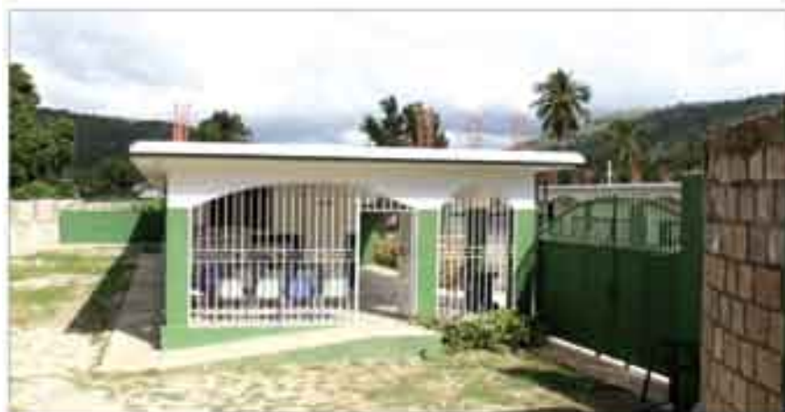
Construction du Centre de Santé d'Areguy Financement- organisations espagnoles, MSPP et mairie de Jacmel
