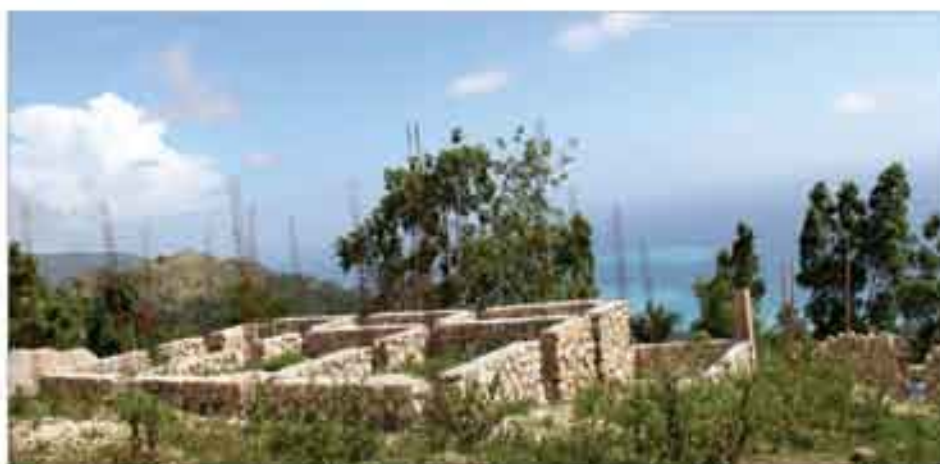
Construction du Centre de Santé de Corail Sault (Marigot) Financement: Trésor Public (Investissement)
