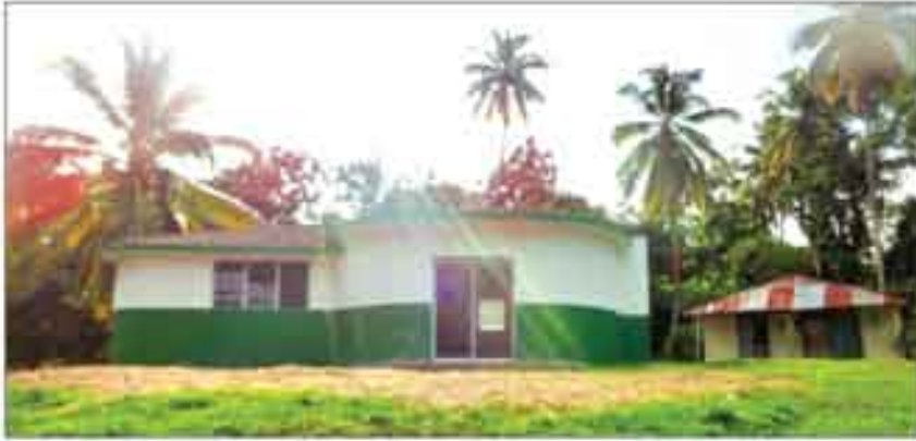
Construction du Centre de santé de Bas Liverne (Dame Marie) - Financement Trésor Public (Fonds Communaux)
