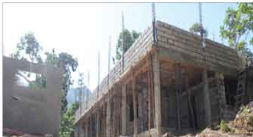
Construction du Centre de Santé de Saut du Baril Financement: Trésor Public (fonds communaux)
