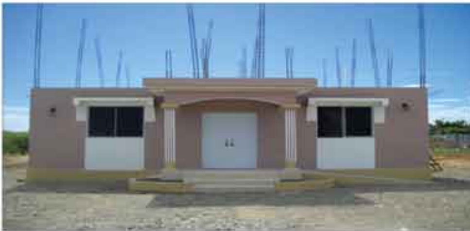
Construction de la Résidence du personnel de Fort Liberté Financement: Trésor Public- (Investissement)
