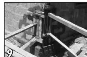
9 Pour 1:2:4 concrete in the columns with proper compaction
