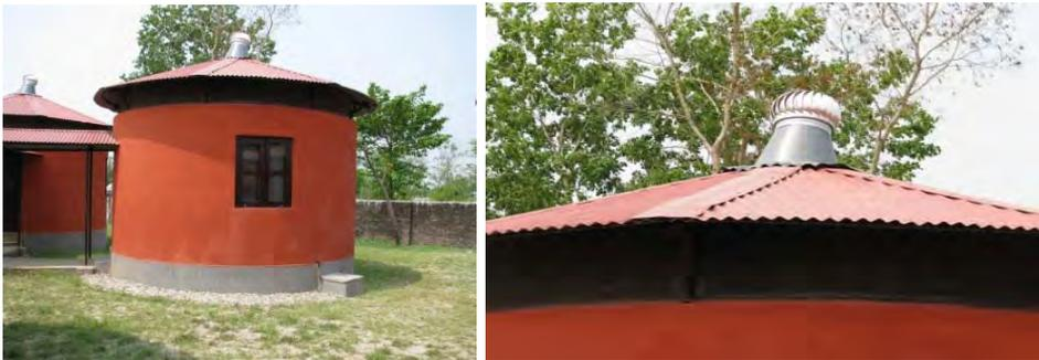
**Figure I.2** Unité d'isolement individuelle (à gauche) et espace libre entre le haut du mur et le toit pour permettre la ventilation naturelle (à droite)
